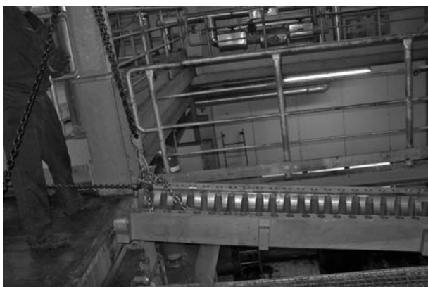
Slika 6. Sanirano cjedilo EP 16 pužne preše prilikom montaže u uljari
